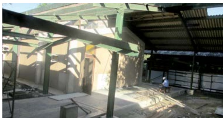
No ICHL, prédio destelhado será Departamento de Comunicação
