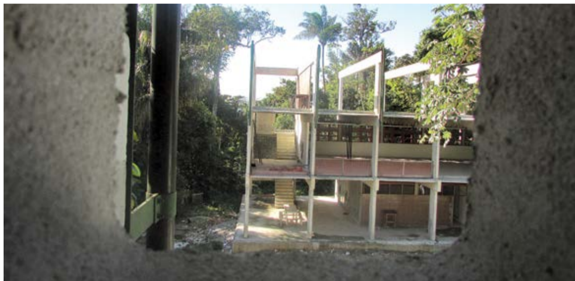
No Icomp há duas obras em andamento., uma delas com nove meses de atraso, segue em ritmo lento
