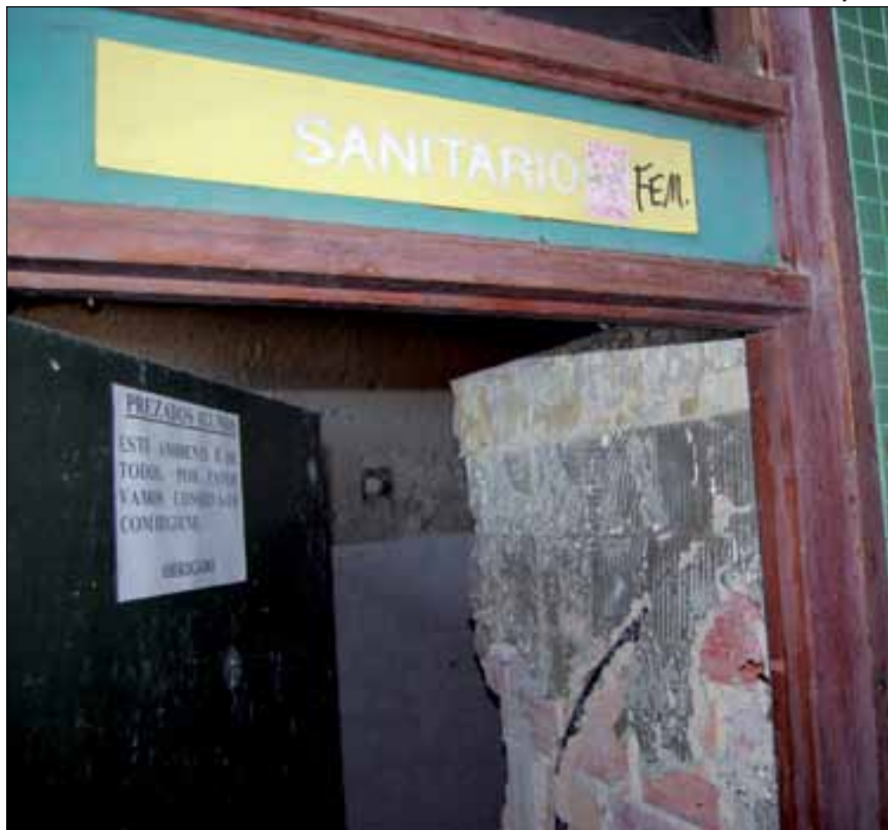
Banheiros desativados é um dos problemas encontrados pelo ICHL
